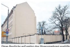
Diese Baulücke soll später das Museumsdepot ausfüllen. FOTO: KÖSTER
